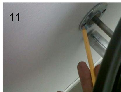
Smontare la struttura e praticare i fori per i fissaggi
